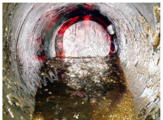
«Вынос» - парафин, песок, ил, грязь и т.д. после пропуска очистного поршня Семигор-ЛС-219 по нефтепроводу.
