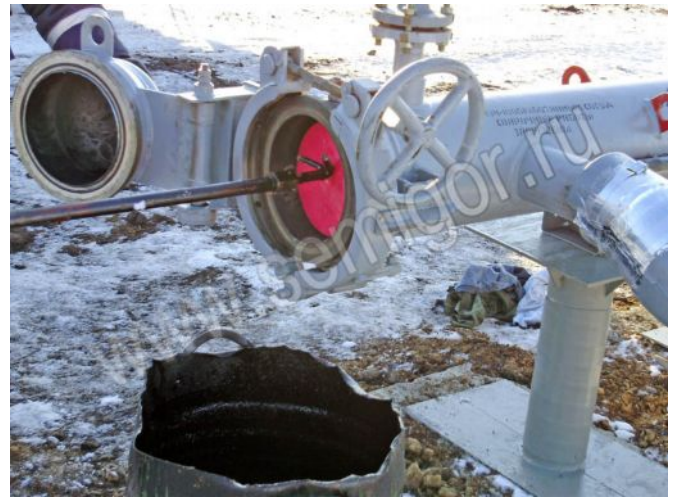
Запасовка очистного поршня Семигор-ЛС-219 в камеру запуска очистных поршней с помощью «толкателя».
