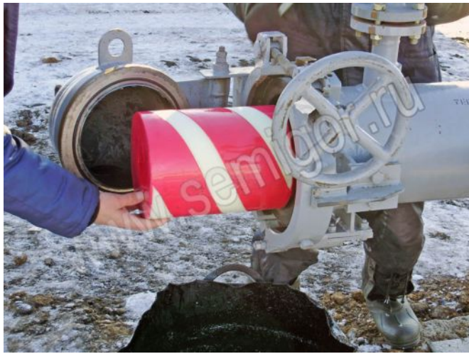
Поролоновый очистной поршень Семигор-ЛС-219 перед запасовкой в камеру запуска участка нефтепровода \varnothing 219 \times 8 мм, длиной 8,4 км
