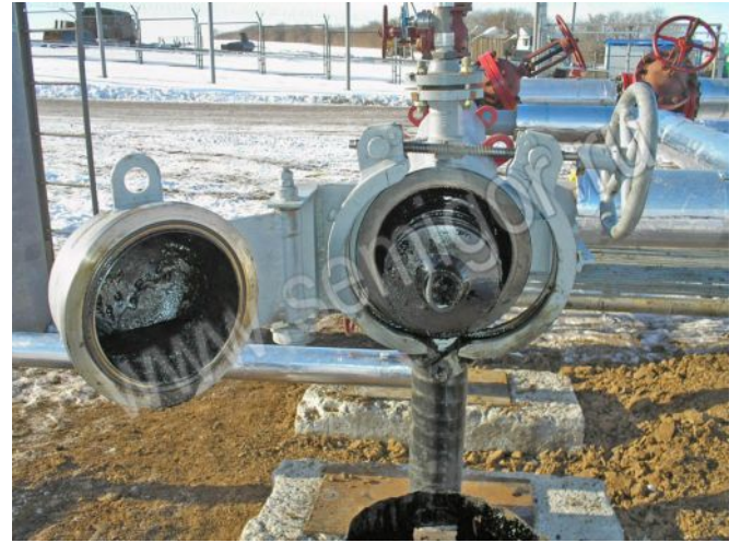
Очистной поршень Семигор-5Д1М-219 в камере приёма очистных поршней. (вид поршня спереди)
