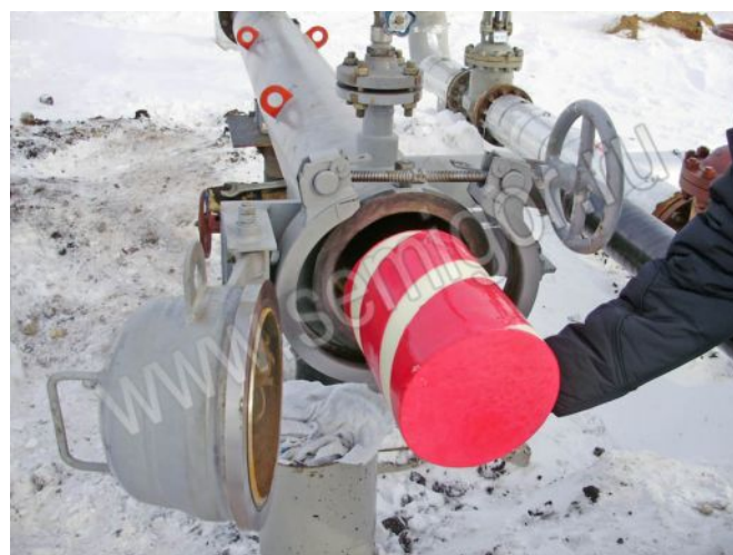
Запасовка поролонового очистного поршня Семигор-ЛС-219 в камеру запуска нефтепровода \varnothing 219 \times 8 мм, длиной 8,2 км.
