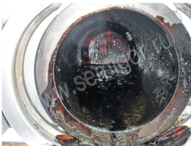
Семигор-ЛС-219 в камере приема очистных поршней. Перед поршнем «вынос» из нефтепровода \approx 3 литра — парафин, ил, песок, грязь.
