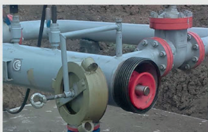
Поршень в камере запуска.
