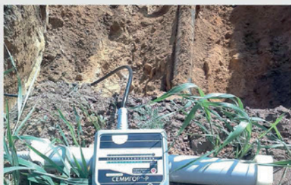
Раскопка трубопровода в месте остановки поршня.
