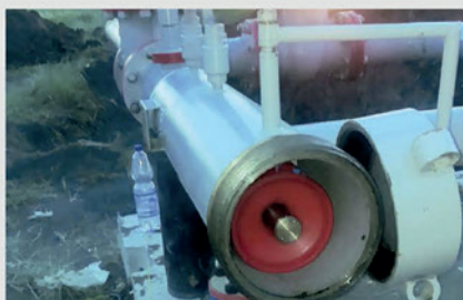
Поршень в камере запуска.
