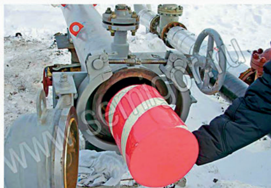
Нефтепровод – 219х8 мм длиной 8,2 км Запасовка поролонового очистного поршня Семигор®–ЛС40–219 в камеру запуска нефтепровода.
