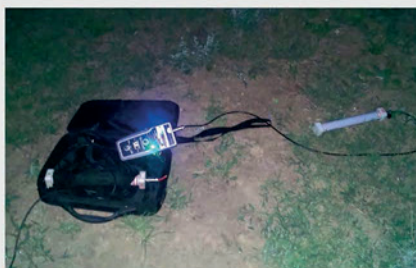
Отслеживание прохождения поршнем контрольных пунктов трубопровода через каждый километр, двумя бригадами сопровождения.
