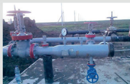
Запасовка поршня до сужающейся части камеры запуска.
