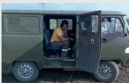
Отслеживание поршня с использованием приемника сигнала от передатчика Семигор®-Р и акустического приемника Семигор®-АП.
